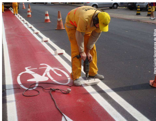
Figura 4 Construção de ciclofaixa – Florianópolis, 2008.
